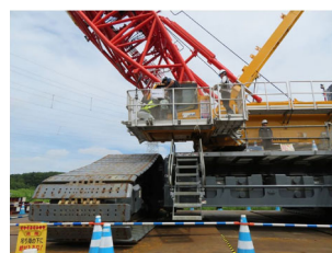
クレーン運転席見学状況
