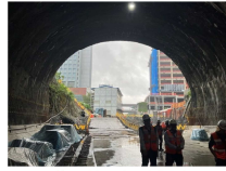
坑口（トンネル内から）
