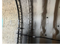
鋼製支保工（展示室）
