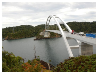
出島大橋全景
