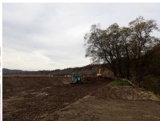
河道掘削状況
