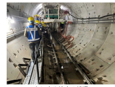
トンネル坑内の状況
