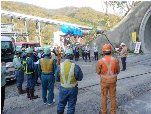
共和工区見学状況
