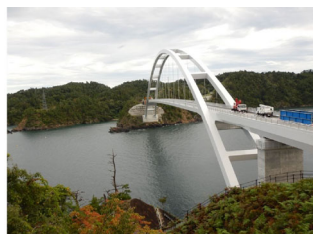
出島大橋全景
