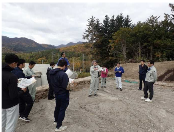
旭川開発建設部職員による工事説明
