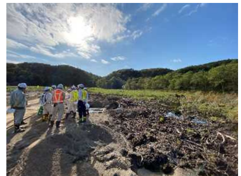
サンヌシ地区地盤改良工事の見学の様子
