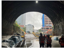
坑口（トンネル内から）
