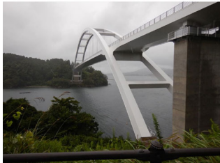
気仙沼大島大橋全景
