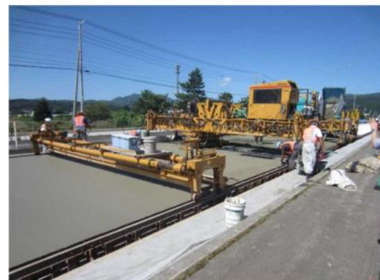
コンクリート施工状況
