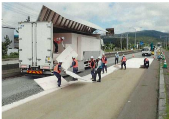
断熱材設置状況
