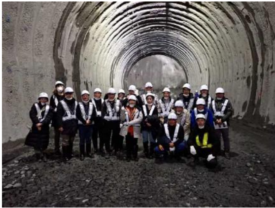
後志トンネル工事（塩谷）
