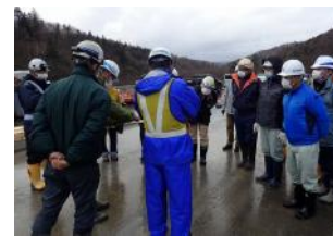
稲葉副所長および施工会社 による法面对策工事説明
