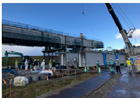
写真－１ 工事概要の説明
