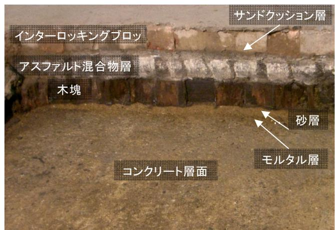
写真-1 試掘調査時の舗装断面
