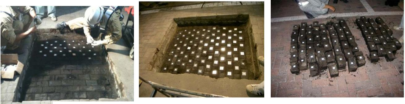
写真-2 試掘調査時の木塊舗装 ※白く光るのは管理用のナンバリングプレート
