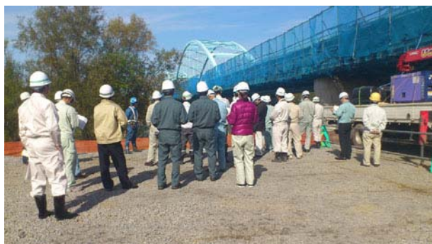
深川橋の現場説明の状況
