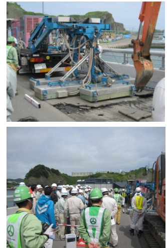
写真 1 IH 式舗装撤去工法見学会の様子
