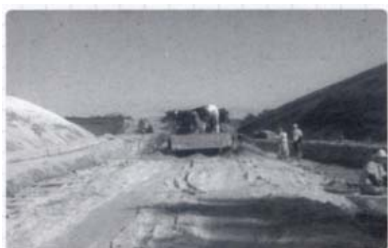
置換材料に現地産の火山灰を使用
