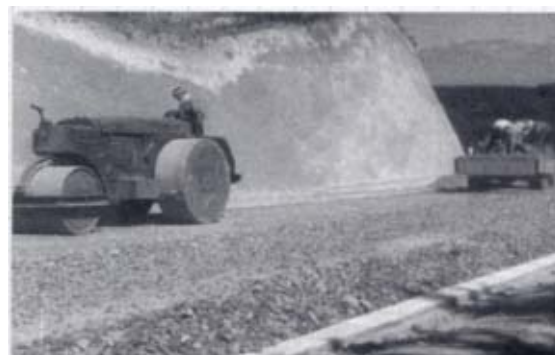
碎石基礎の転圧作業
