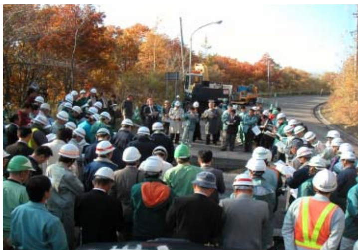
開削現場の見学会の状況
