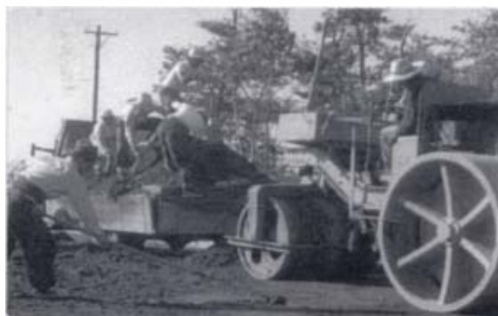
転圧コンクリートの敷き均し作業
