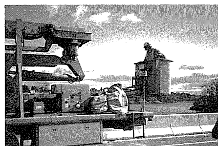
写真-4 点検作業状況
