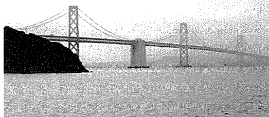
写真-13 オークランド・ベイ橋(吊橋部)
