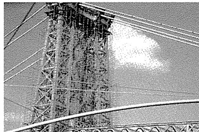
写真-6 ウィリアムズバーグ橋補修工事状況
