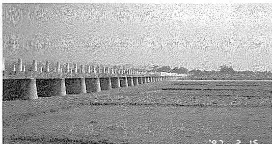
ガンジスの支流ラトー河に架るスラブ橋、雨期のみ流れがある（東西ハイウェイ道路）
