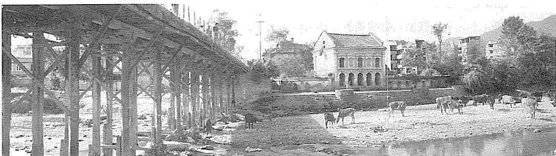
首都カトマンズ市内を流れるビシヌマティー河に架る架橋後80年を経て供用中の老朽化した木造橋（カトマンズ市内）
