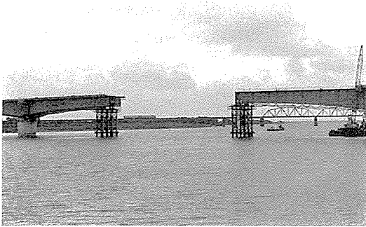
写真-1 (架設前の状況)
